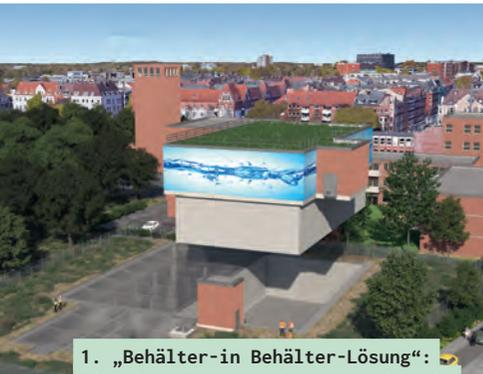
1. „Behälter-in Behälter-Lösung“: Die alten Betonwandungen werden als „tote Schalung“ genutzt und ein neuer Betonbehälter wird eingesetzt
