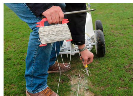
Mit Schraubendreher und Bindfaden richtet Jahn die Linien aus
